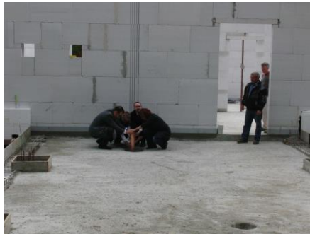
Die Grundsteinlegung für das Umweltbildungszentrum am 4. Mai 2010
